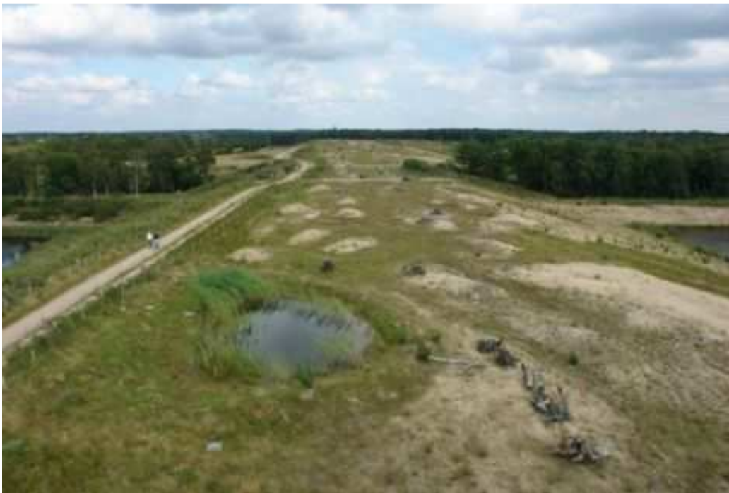
Overzicht over Natuurbrug Crailoo van west naar oost vanuit de voormalige uitkijkpost. De N524 (Naarderweg) en het spoorassemblage onder het ecoduct zijn nauwelijks zichtbaar.
